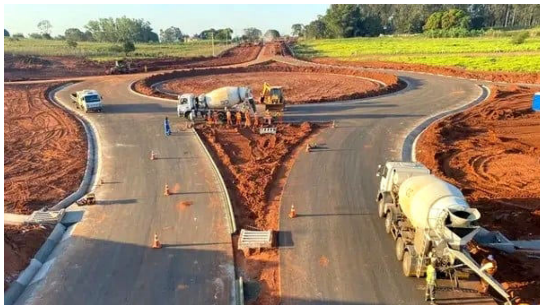
Obras na BR 367, na região do nordeste de Minas.
